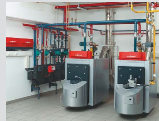
Vitotronic 300-K ile 4 adet kazana kadar kaskad kontrol
