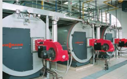
Üç geçişli düşük basınçlı buhar kazanı Vitomax 200-LS ile kurulmuş bir kazan dairesi
