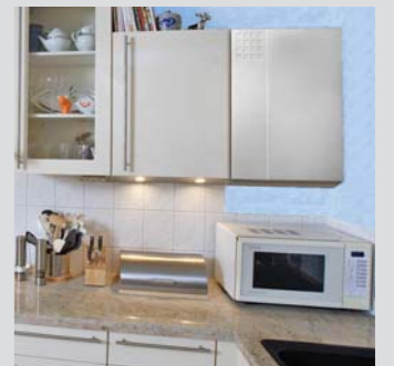
Uygulamada konut sıcak su istasyonu
