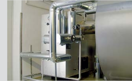
Ekonomizör ile baca gazı yoluyla atılan duyulur ısı geri kazanılır.
