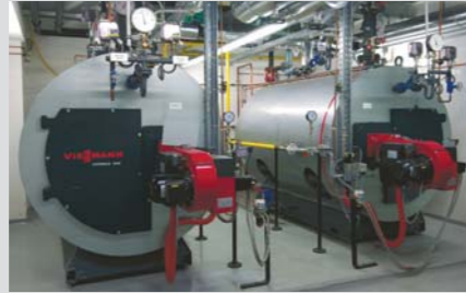
Üç geçişli kızgın su kazanı Vitomax 200-HW ile kurulmuş bir kazan dairesi
