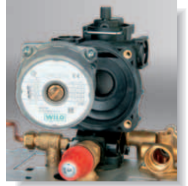
Pompa ile birlikte filtre ve hava purjörü
